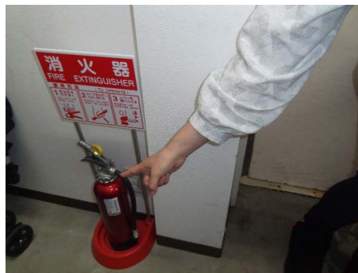
避難口・消火器の点検
